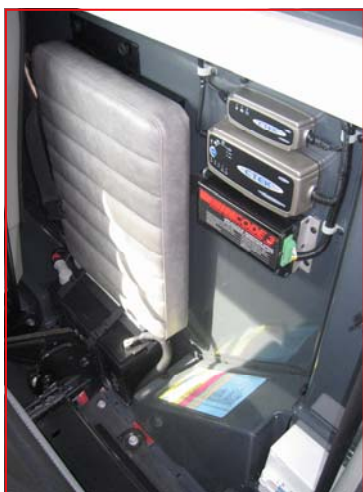
Côté séparation cabine
